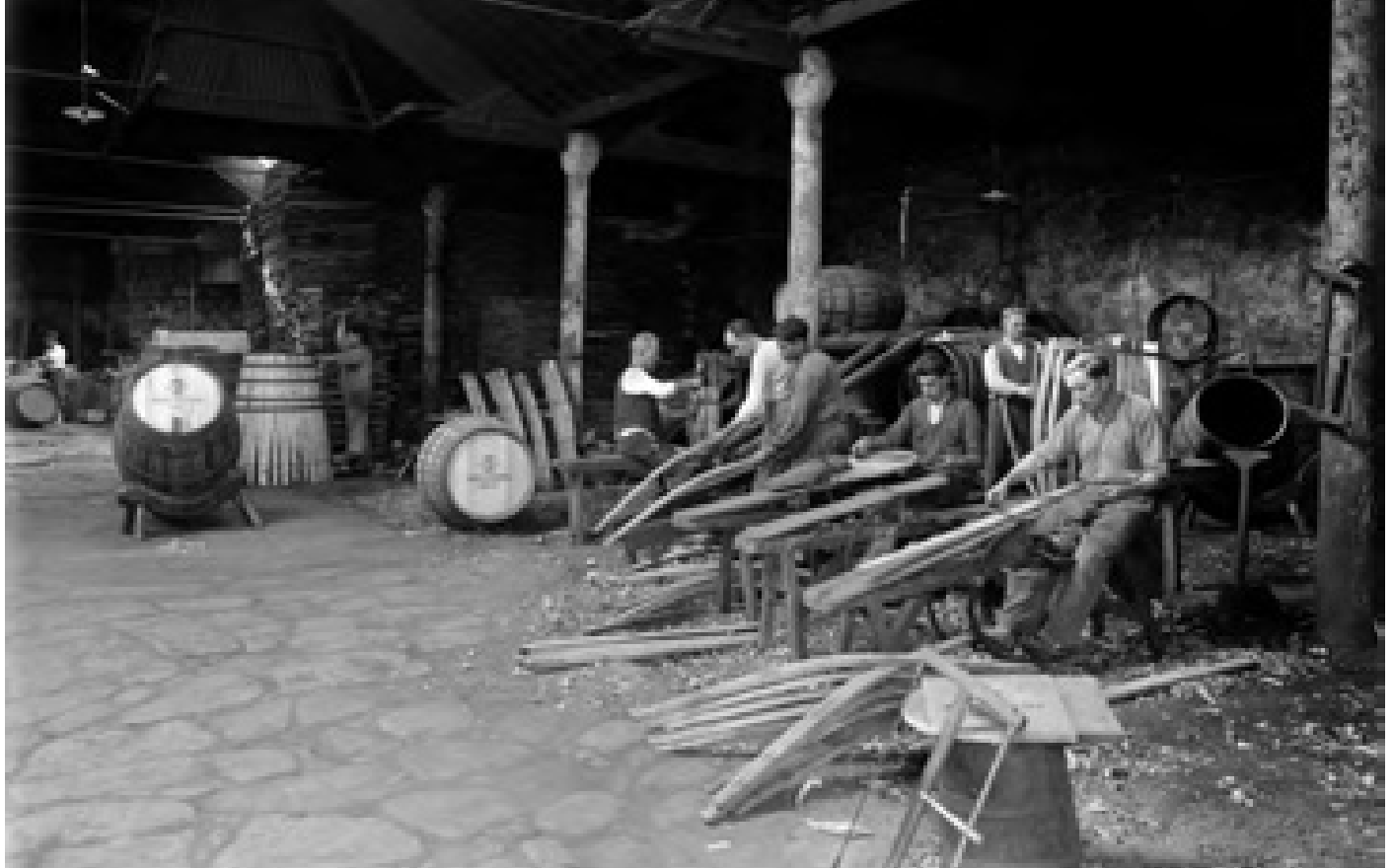
Fig. 48 Vila Nova de Gaia. Tanoaria da Pinto Pereira & Filhos, Lda. Pinto Pereira & Filhos, Lda. cooperage
